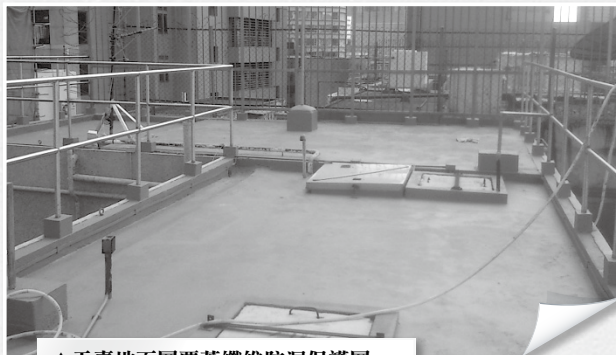
▲天臺地面層覆蓋纖維防漏保護層
